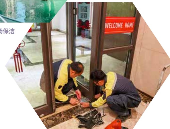
图2 物业进行工程维修
