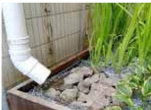
图1 屋面雨水断接措施
