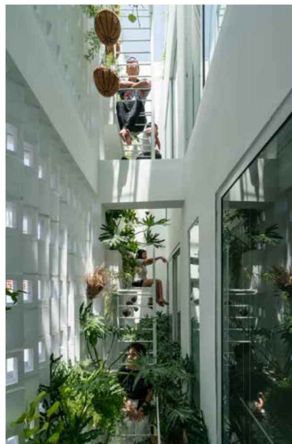
房子背面的轻质砖墙体将空气和阳光带进了房子里，同时也阻挡了夏天的日晒高温和冬天的湿冷空气。这个“百叶窗”墙体结合天窗和外立面上的玻璃门使用，确保了在白天的时候阳光分布充足，也带来了通风并创造了空气对流。
