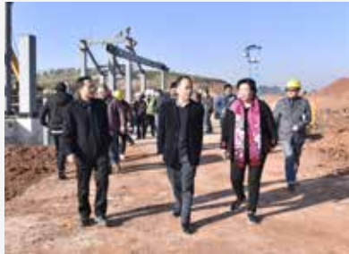
住房城乡建设厅副厅长封宁一行实地考察南宁国际园博园东盟馆等景观工程的建设现场
