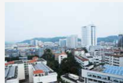
百色市右江民族医学院附属医院公共建筑节能改造示范项目
