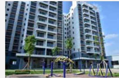
百色市田东县保障性安居工程项目
